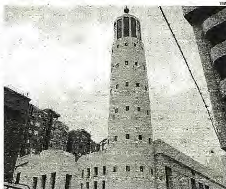
El edificio Kursaal será la sede en la que se realizarán estos cursos.
