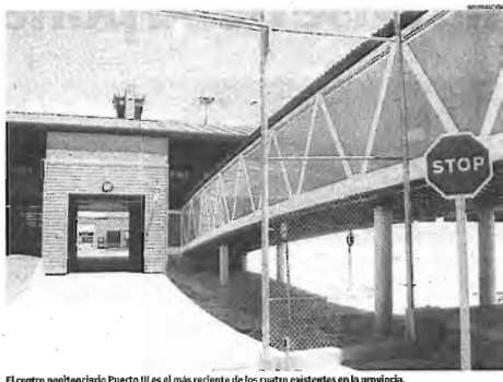
El centro penitenciario Puerto III es el más reciente de los cuatro existentes en la provincia.
