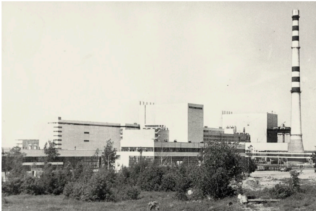
Первый блок Ленинградской АЭС. Сосновый Бор, 1969 год.
